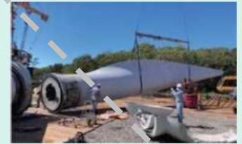
例：風力発電のブレードの解体
