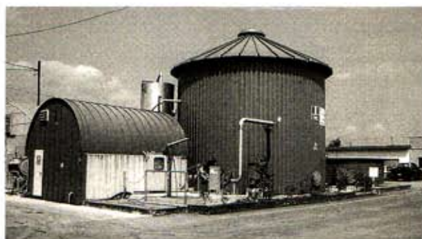
バイオガスプラント全景 (手前:エンジンルーム 中:バイオガスリアクター 奥:消化液タンク)
