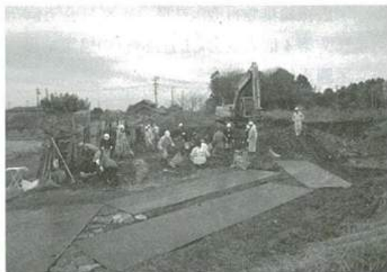
参加者の撤去作業
